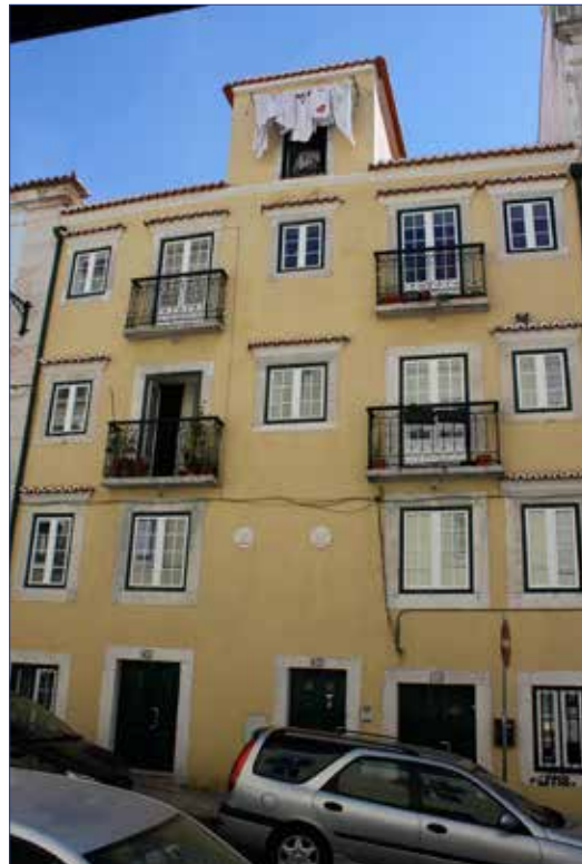
Figura 2 Calçada de Santana, nº 202-206. Fotografia de João Vieira Caldas.
