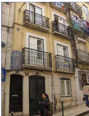
Figura 12 Calçada de Santana, nº 85-87. Fotografia de Ana Rosado
