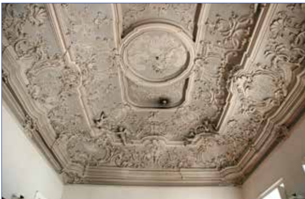
Figura 3 O palácio de Fernando de Larre, na calçada do Combro, em Lisboa. Teto do salão nobre. Fotografia de Tiago Antunes 91 .
