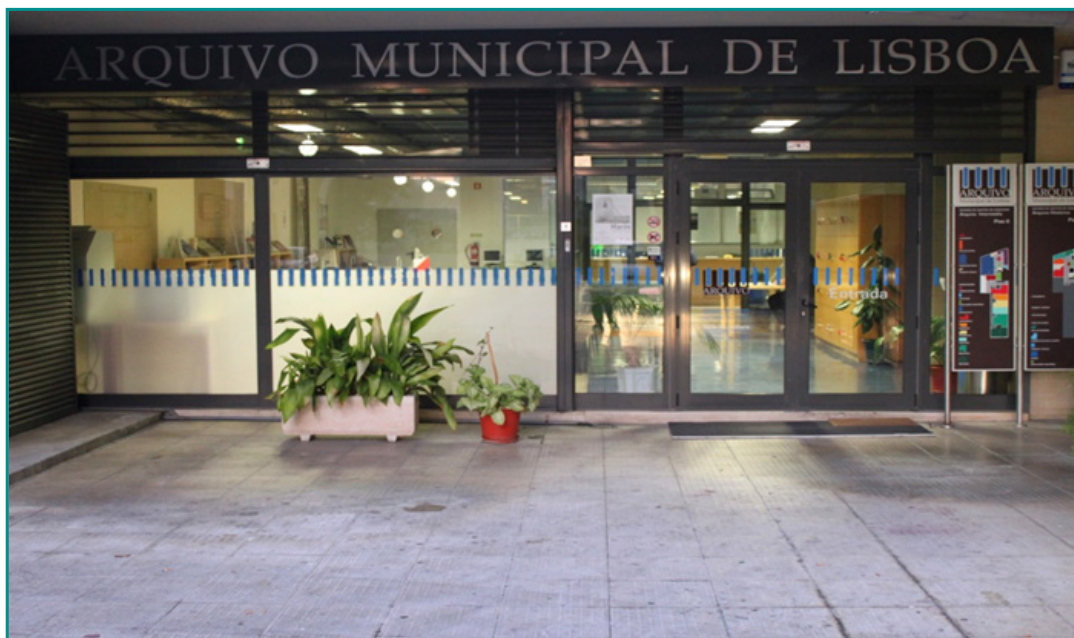
Figura 3 Arquivo Municipal de Lisboa (bairro da Liberdade). Fotografia do autor
