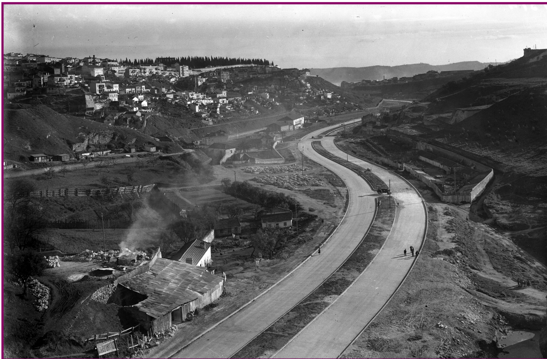
Figura 14 AML, Eduardo Portugal, Avenida de Ceuta , 1950.
