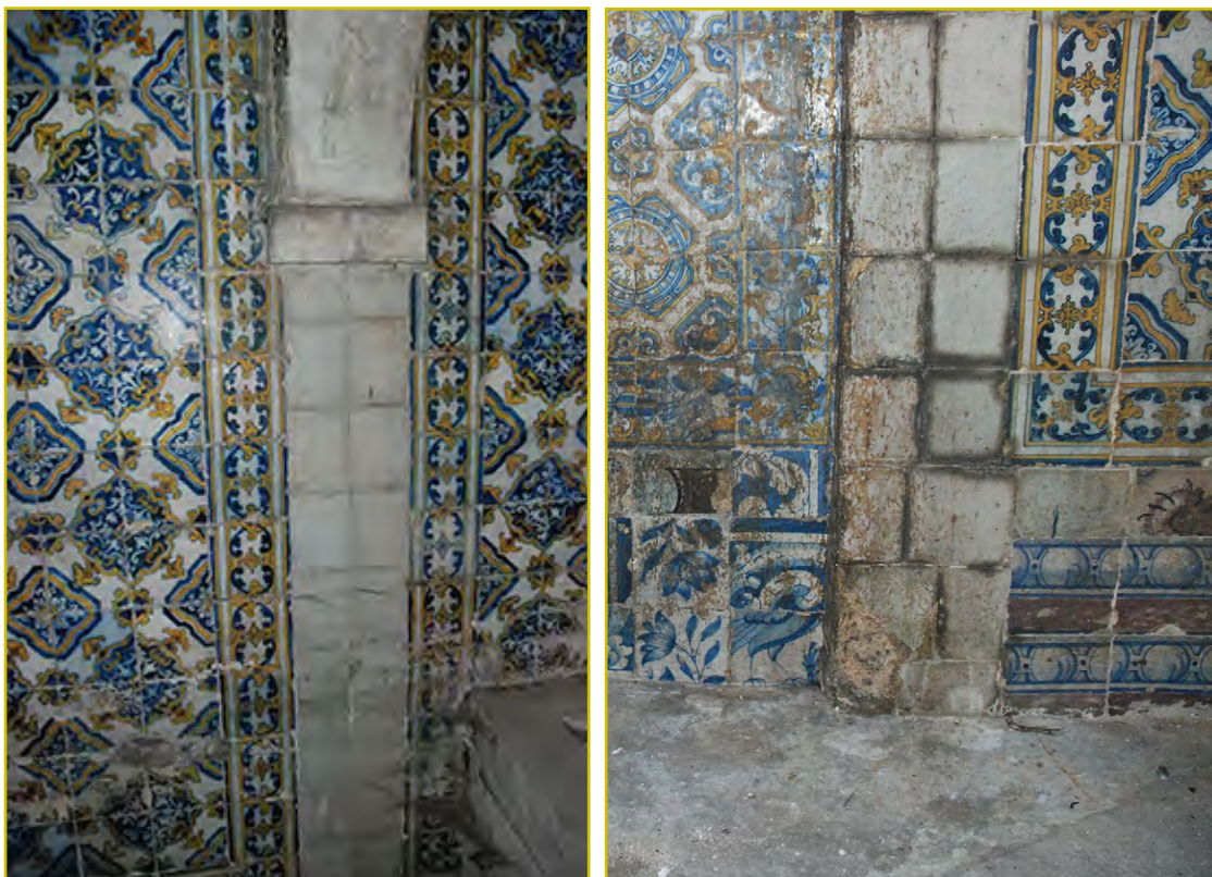
Figuras 9 e 10 Primeiro momento do revestimento azulejar: azulejos brancos e lisos, típicos da segunda metade do século XVI, utilizados em todo o país em revestimentos enxaquetados. Estes azulejos assumem a imagem de pilastras prolongando a linha do arco até ao pavimento em pedra. São assim associáveis à arquitetura do espaço, em particular aos arcos e ao pavimento. São os únicos que se relacionam com o pavimento de pedra. Fotografias do autor, 28-11-2013.
