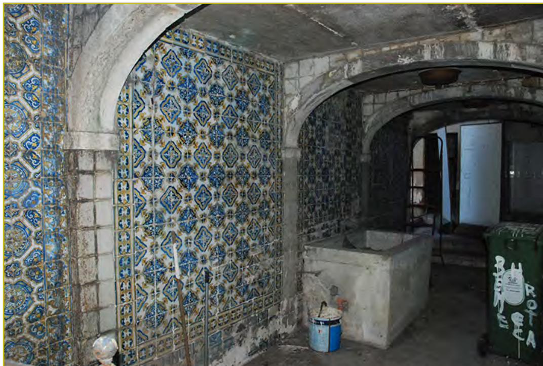
Figura 6 Aspeto geral do interior da estrutura arquitetónica associada à cisterna, onde se preserva uma cuba de pedra e alvenaria. Fotografia do autor, 28-11-2013.
