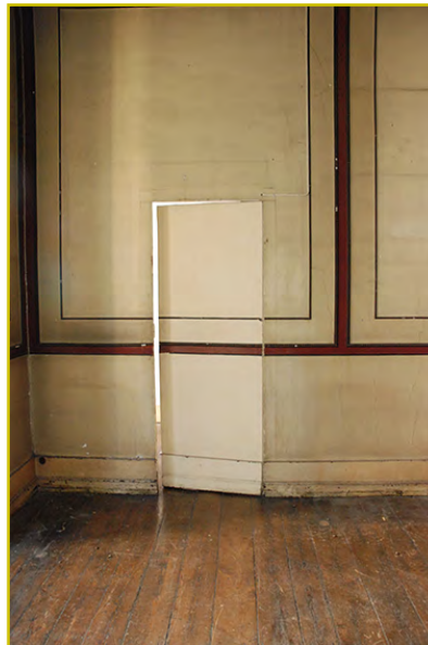
Figuras 16, 17 e 18 À esquerda: alçado do Palácio dos Condes de Tomar na Rua de São Pedro de Alcântara, n.º 1, o qual pretende dar a ilusão que pertence ao palácio vizinho através da cópia das molduras da fachada, cêrcea da cobertura, etc. Ao centro, porta dissimulada na parede do piso do andar nobre, a qual dá acesso a um pequeno gabinete. À direita, armário encastrado na parede do gabinete secreto onde eram guardados os valores do proprietário do edifício. Fotografias do autor, 28-11-2013.
