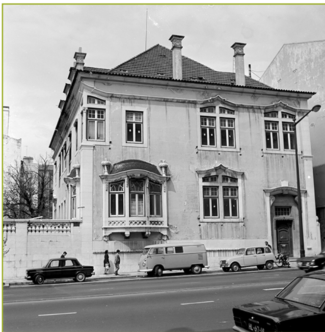
Figura 5 Moradia a demolir. Av. Fontes Pereira de Melo, n.º 17. Casa Ribeiro Ferreira. Artur Bastos Inácio (1969). AML, PT/AMLSB/AIB/S01760
