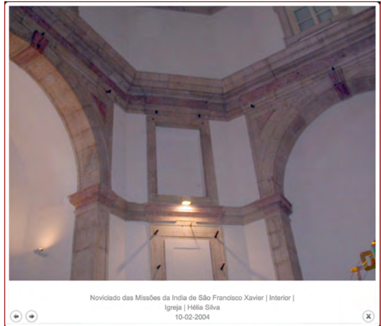
Figura 14 Interior da igreja do Noviciado de Arroios. Imagens retiradas do site http://patrimoniocultural.cm-lisboa.pt/lxconventos/ficha.aspx?t=i&id=652 [consultado em 21.01.2017].
