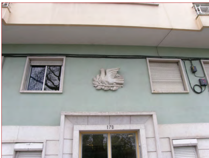
Figura 8 “Entalado” de José Farinha em edifício da avenida do Brasil, n.º 170 (arq. Sérgio Botelho de Andrade Gomes), c.1956. Fotografia da autora.
