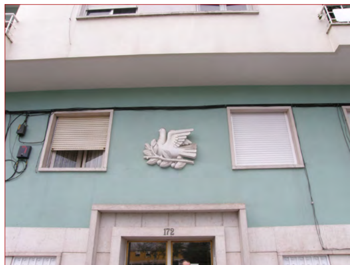
Figura 9 “Entalado” de José Farinha em edifício da avenida do Brasil, n.º 172 (arq. Sérgio Botelho de Andrade Gomes), c.1956. Fotografia da autora.
