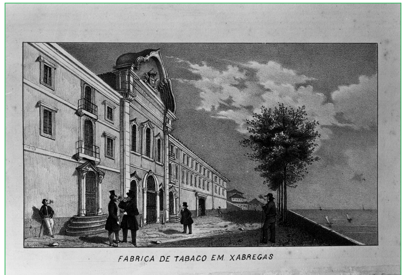
Figura 2 Vendido depois da revolução liberal, no edifício do Convento de São Francisco de Xabregas instalou-se uma fábrica de tabaco. Gravura da época. AML, PT/AMLSB/CMLSBAH/PCSP/004/MNV/001755.
