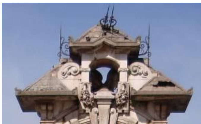
Figura 24. Cobertura do arco, 2011.
