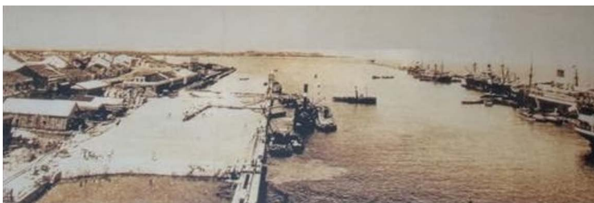
Figura 2. Aterros para a construção do Porto, 1910
