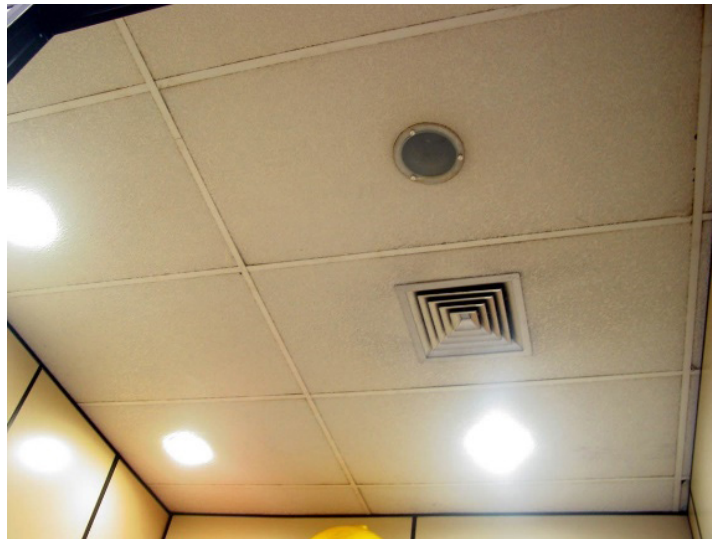
FIGURA 7 Detalhe do teto e da iluminação utilizada na Sala de Terapia Ocupacional e Visual da AACD
