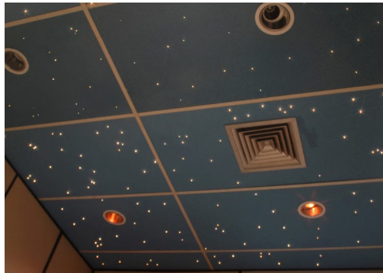
FIGURA 8 Detalhe do teto após a aplicação do efeito céu estrelado com fibra ótica
