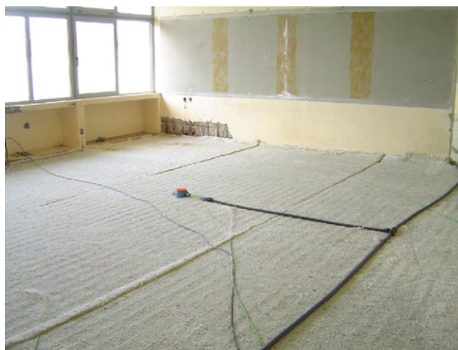
Fig. 4 - Instalação do sistema de rega para manter a humidade.
