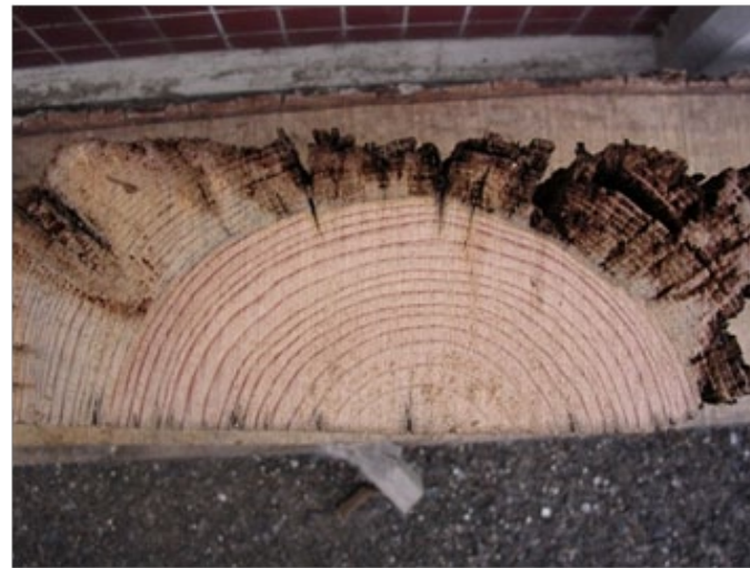
Fig. 11 - Ataque de podridão na zona mais suscetível da madeira - o borne.
