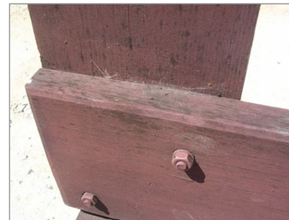
Fig. 16 - Estado do acabamento com óleo pigmentado ao fim de três anos de exposição ao sol e à chuva.
