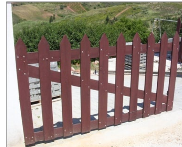
Fig. 15 - Portão de quintal em madeira de pinheiro bravo e com acabamento à base de óleo pigmentado.
