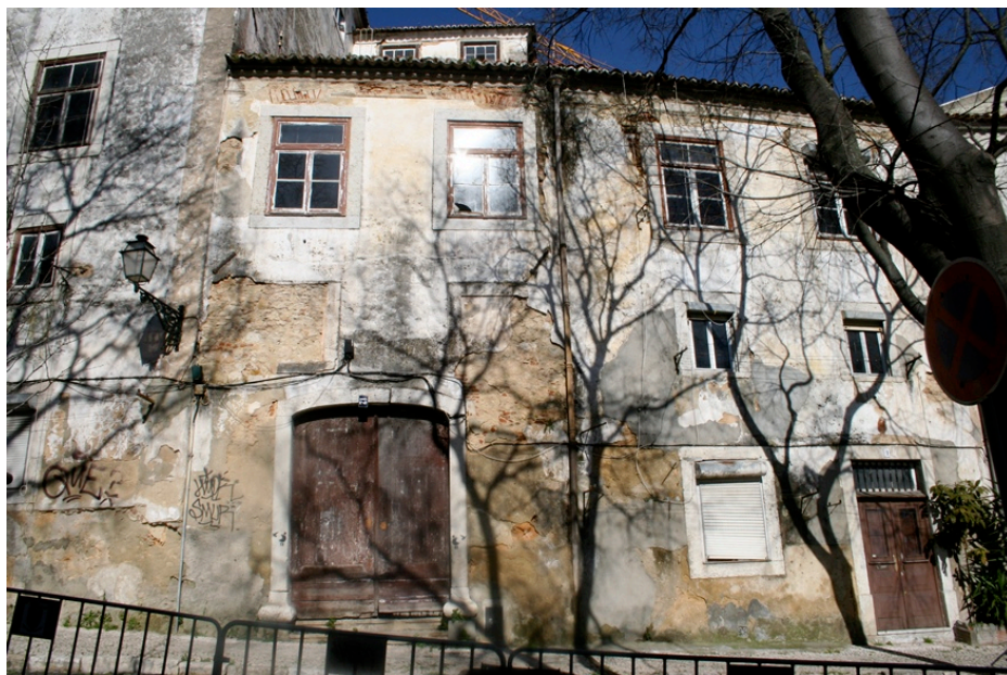
Fig. 2 – O edifício do Hotel Santiago de Alfama (exterior), antes das obras de reabilitação e conversão para unidade hoteleira. Figura a cores disponível online.
