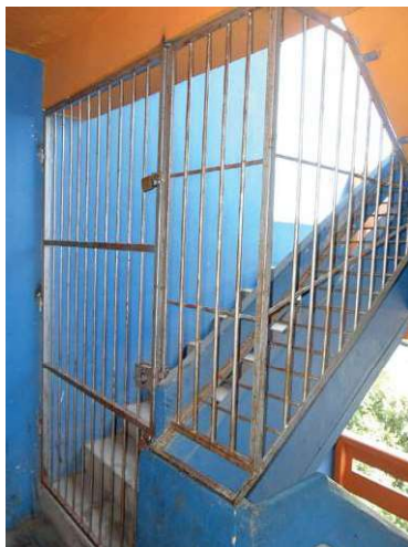
Figuras 17 e 18 ▶ Controlos do espaço nas galerias. Bairro do Condado, Zona J, e bairro dos Lóios, Pantera Cor-de-Rosa, Marvila, Lisboa
