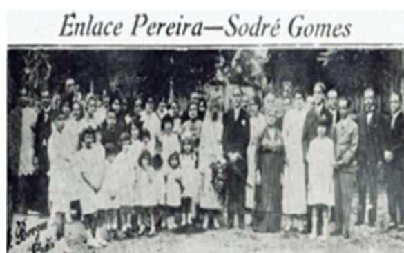
Figura 10 ▶ Casamento em Belém
