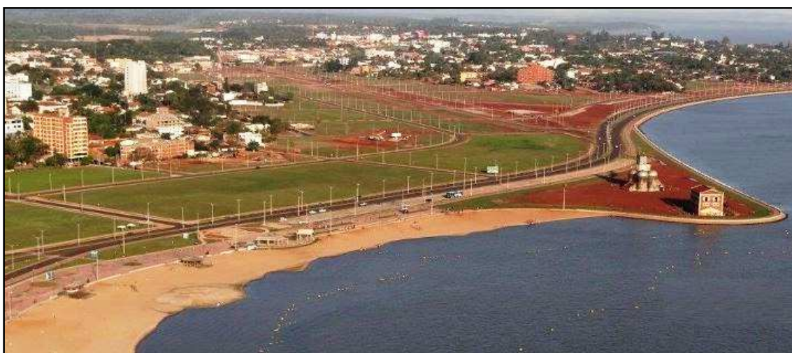
Figura 2 – Avenida Costanera José Asunción Flores após a urbanização da orla Fonte: C. ESTIGARRIBIA, 2012.
