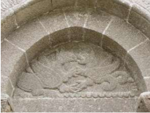
Figura I - Tímpano do Portal Norte
