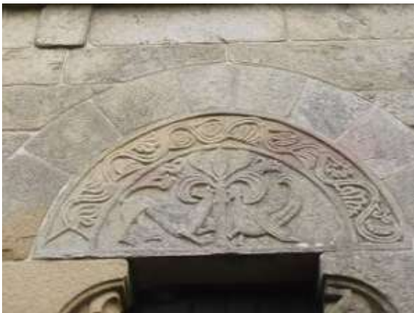
Figura II - Tímpano do Portal Norte da Capela de Nossa Senhora da Orada
