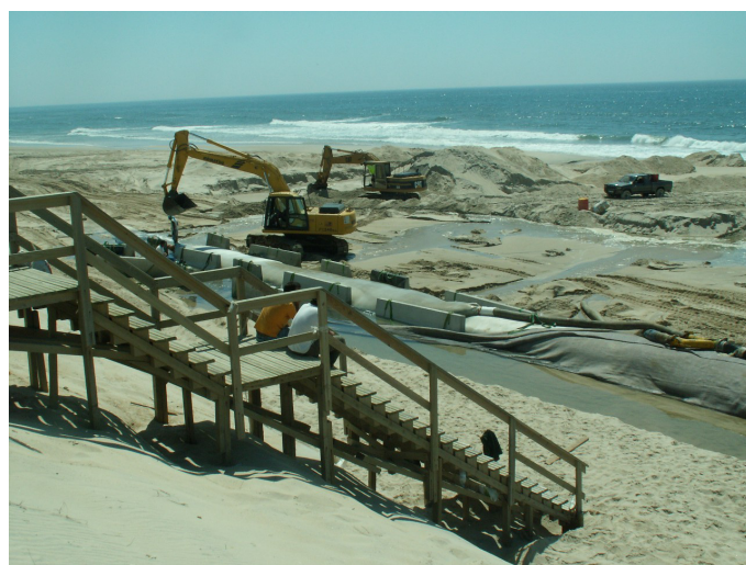
a) Tubos pré-fabricados em material geotêxtil: processos de instalação e enchimento em 14 de julho de 2008.
