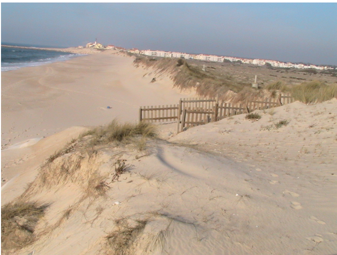
Figura 6. Fotografia obtida sobre a zona que foi objeto de intervenção, em fevereiro de 2013, mostrando o recuo da frente do sistema dunar (já quase inexistente) relativamente ao alinhamento inicial (foto do autor).
