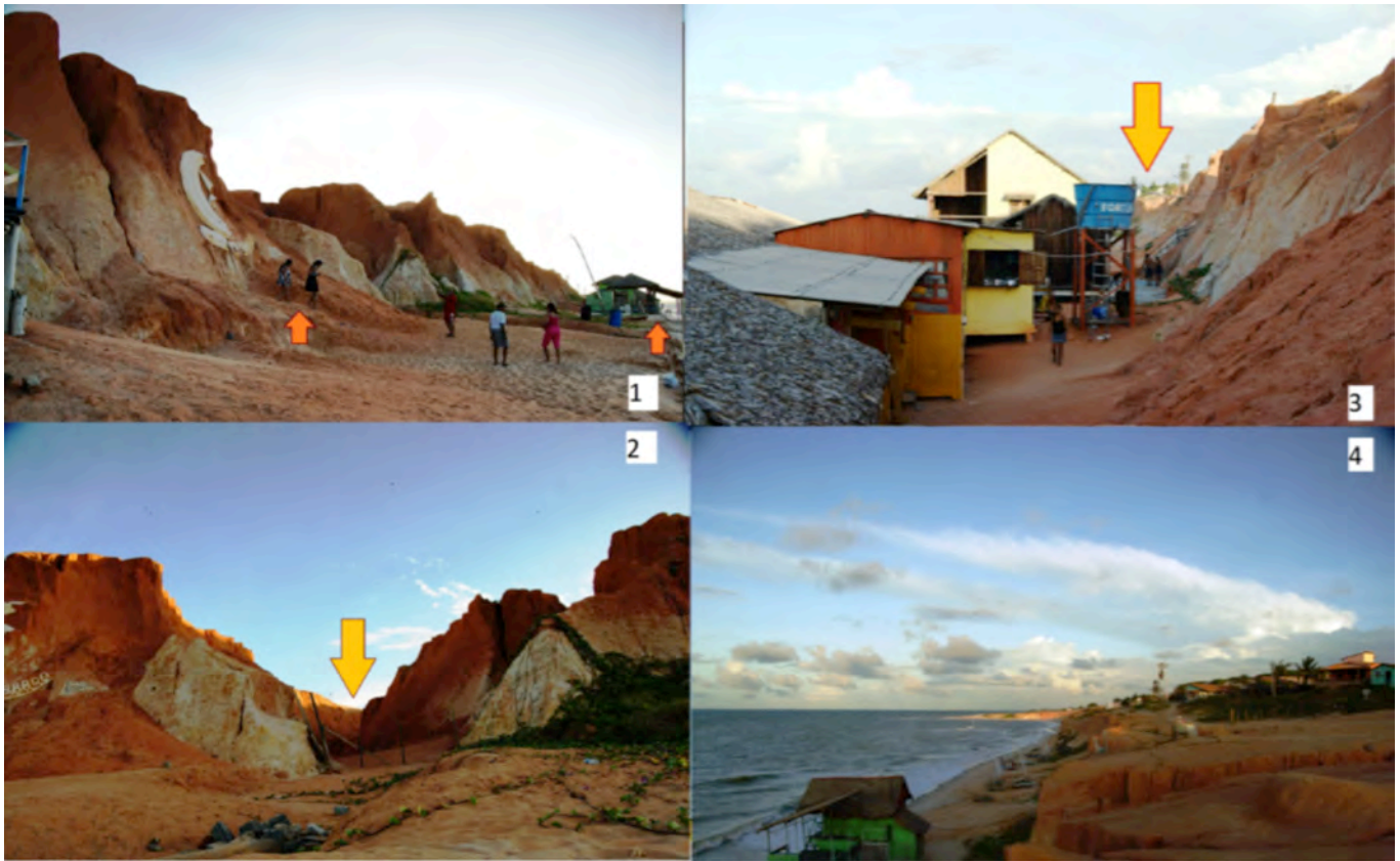
Figura 5 - 1- Pisoteamento, 2- Voçoroca em falésia, 3 e 4- Ocupação irregular em falésia. (APA de Canoa Quebrada, Ceará, Brasil).
