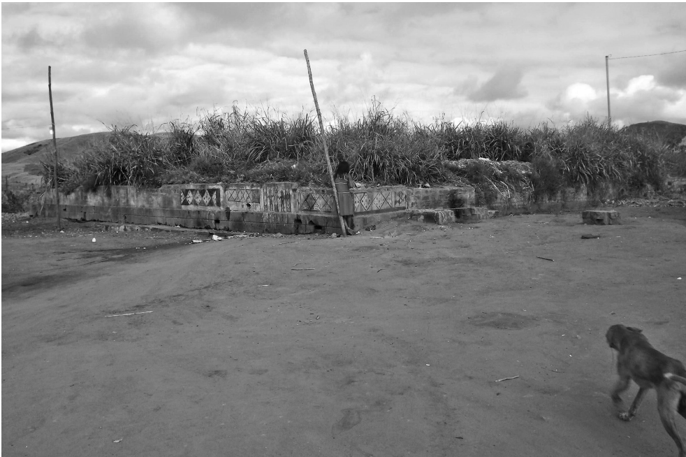
Figura 5 – Ruína de antiga fazenda em aldeia no Pradinho. Fonte: Douglas Ferreira Gadelha Campelo. Fotografia ainda não publicada.
